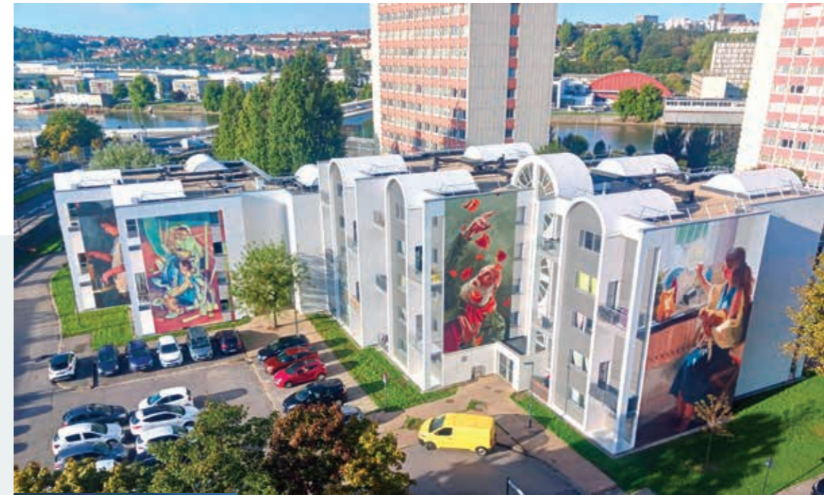
Réhabilitation de la Résidence Rouget de l'Isle à Boulogne-sur-Mer
